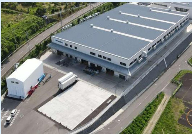
八幡工場外観
