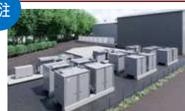
上組日吉原蓄電所（仮称）（大分県大分市） 蓄電コンテナ数：36台 / 81.2 MWh 事業者：上組日吉原蓄電事業合同会社
