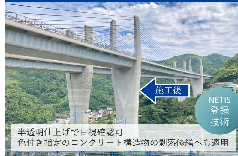
T-oneクリアカラー工法 (半透明仕上げ)
