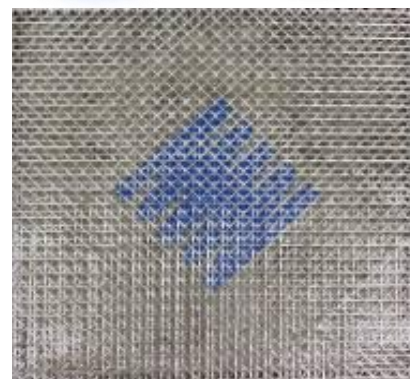
ガラス連続繊維シート設置
